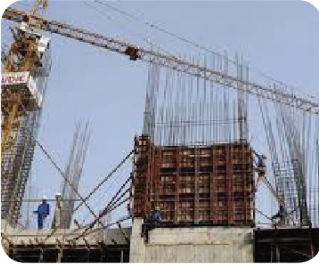
THI CÔNG CÔNG TRƯỜNG
