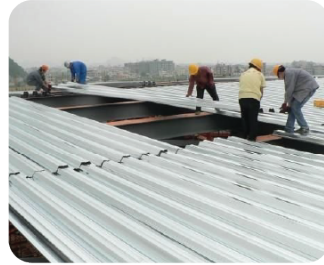
THI CÔNG MÁI TÔN
